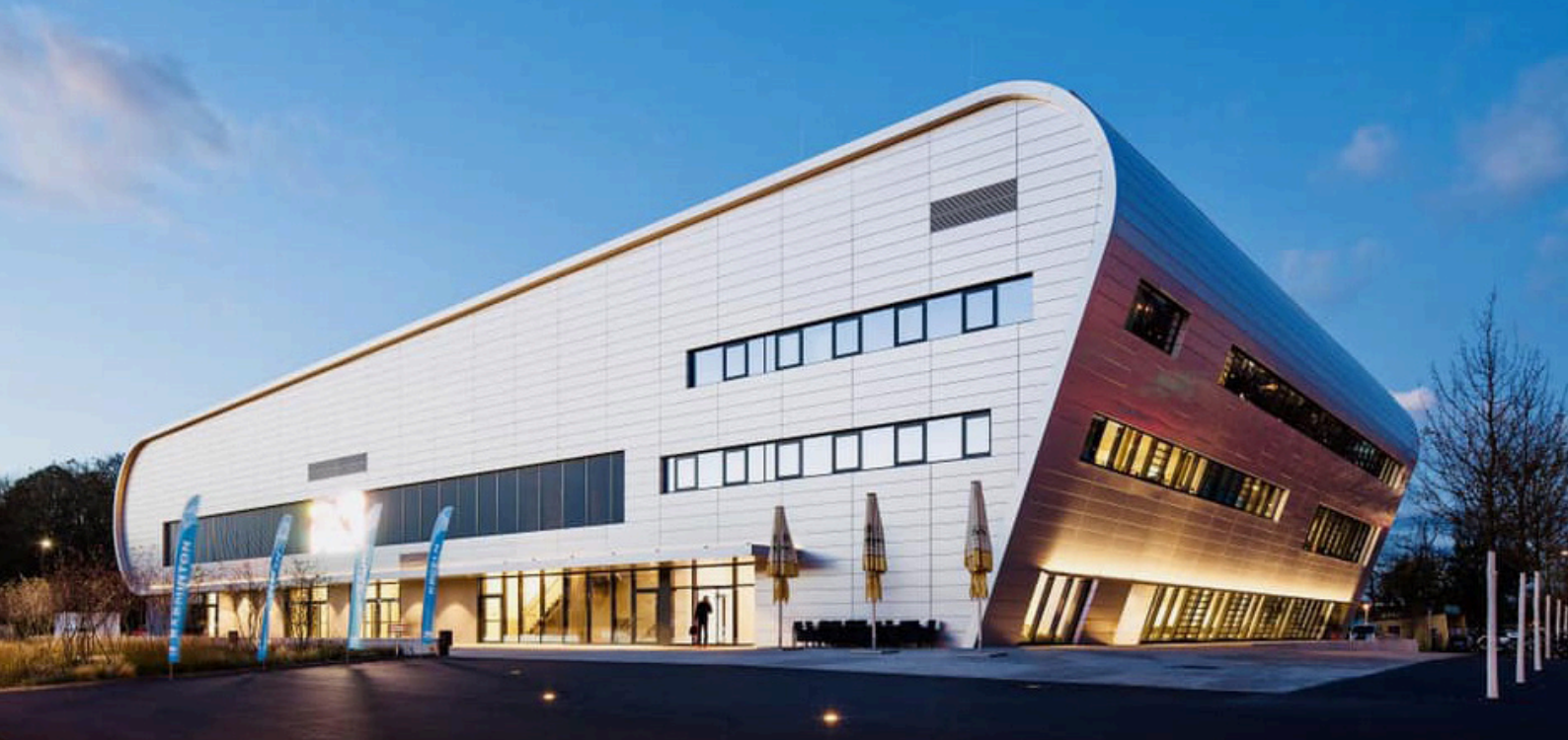
Ballsportarena Dresden: Fehlerfreier Start mit modernster Technik.
